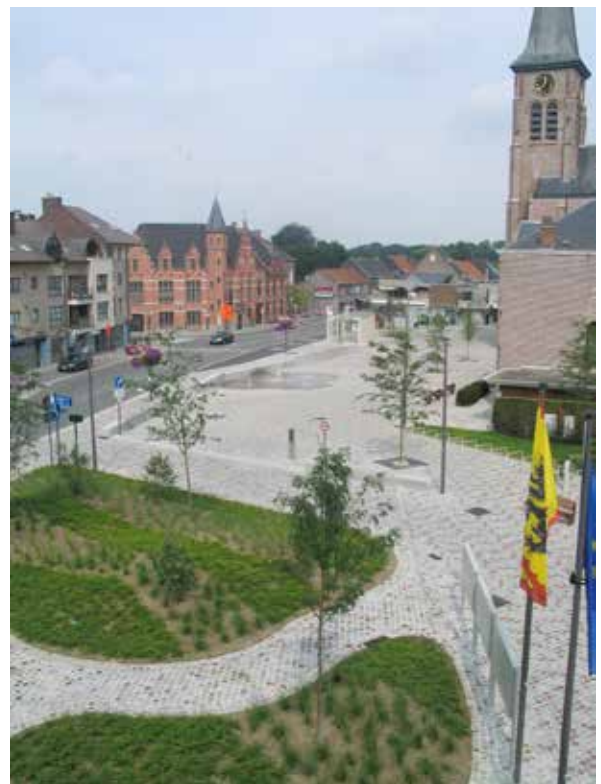
Referentie dorpsplein Merelbeke, SumProject
