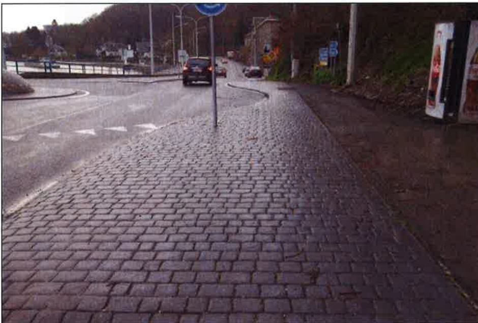
Middenberm in printbeton met kasseiprint
