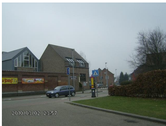
Schoolgebouwen langs de Beringsstraat
